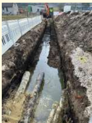
Die Arbeiten zur Verlegung der Rohre schreiten voran
