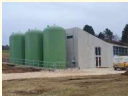
Die Wärmespeicher sind vor Ort
